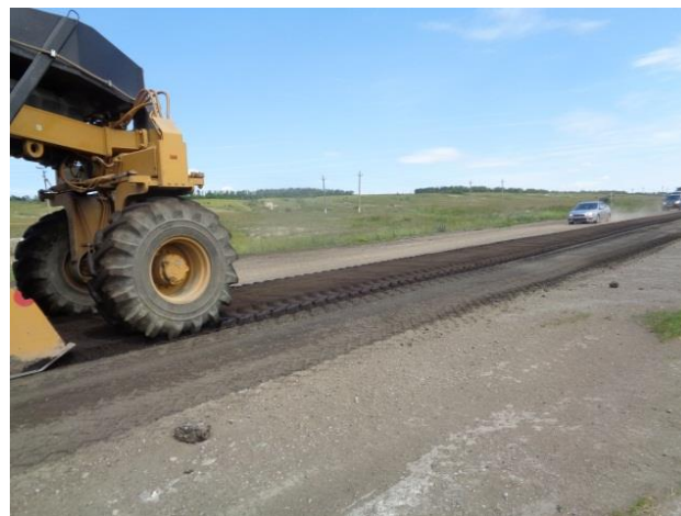
Рис. 1. Специализированное звено машин при выполнении работ по холодной регенерации существующего асфальтобетонного покрытия смешением на дороге
