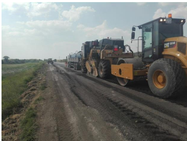
Рис. 1. Специализированное звено машин при выполнении работ по холодной регенерации существующего асфальтобетонного покрытия смешением на дороге
